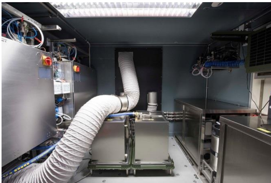
Abb. 4: Abluftleitungen im Technikraum
