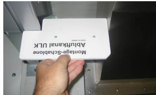
Abb. 7: Abstand Anschlussstück zum Dachträger
