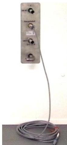
Abb. 2: Schottflansch reiner Bereich, mit montiertem Winkel 90° R1/2" i/a
