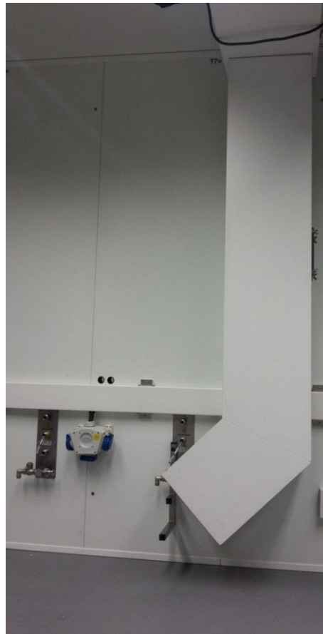
Abb. 9: Einsetzen des Abluftkanals ULK stehend
