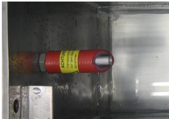
Abb. 10: Draufsicht: Transportsicherung am Schwimmerschalter des Abwassertanks
