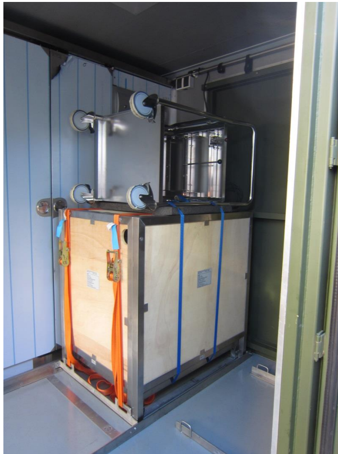
Abb. 6: Befestigung des Transportwagen TW 66 auf der Abwasserhebeanlage
